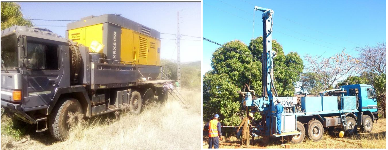
Figure 2 et 3 : l'atelier de forage
