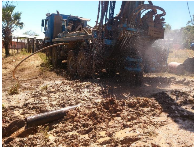
Figure 6 : Essai de soufflage
