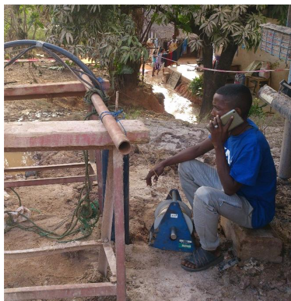
Figure 7 : Essai de pompage
