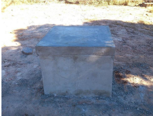
Figure 8 : Mur de protection
