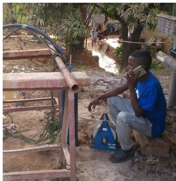
Figure 7 : Essai de pompage
